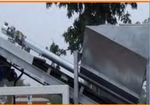
Stockage de chaux 1,2 m 3 avec vis de dosage volumétrique
